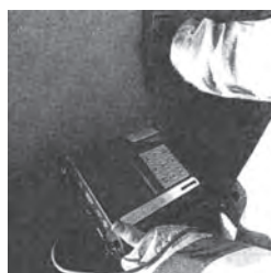
شکل ۸. تست دیوار بتنی با کاورمتر برای جستجوی آرماتورها
