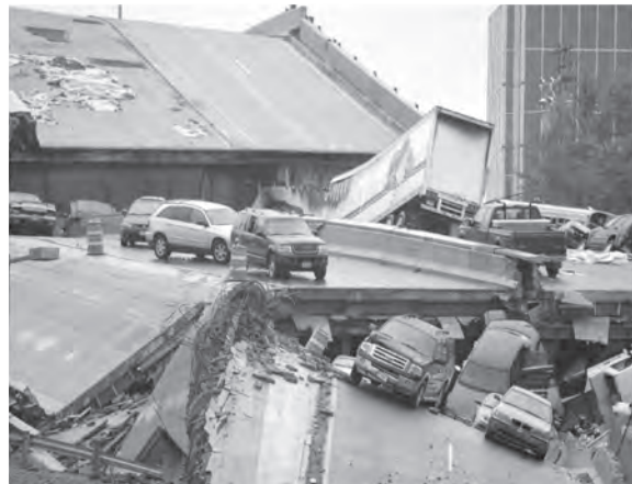
شکل ۲. نمونه‌هایی از پل‌های تخریب شده به علت عدم انجام به موقع بازرسی
